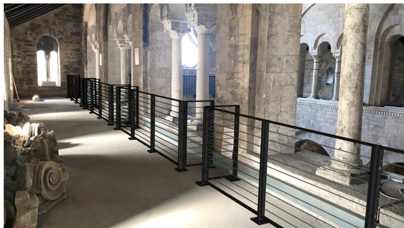
Matroneo nord: IPOTESI PROGETTUALE "C" Ringhiera costituita da telai in acciaio verniciato e cavetti orizzontali in acciaio
