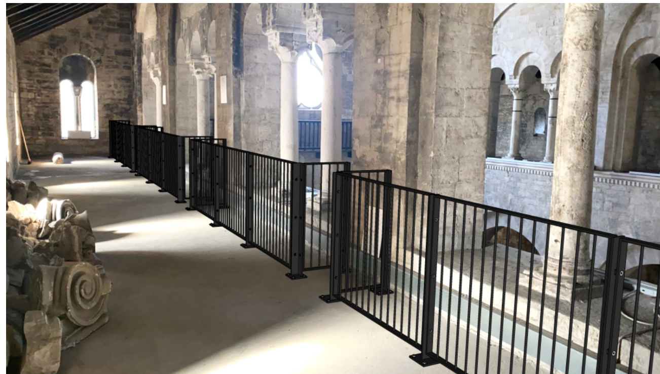
Matroneo nord: IPOTESI PROGETTUALE "B" Ringhiera costituita da telai con elementi tubolari verticali in acciaio verniciato
