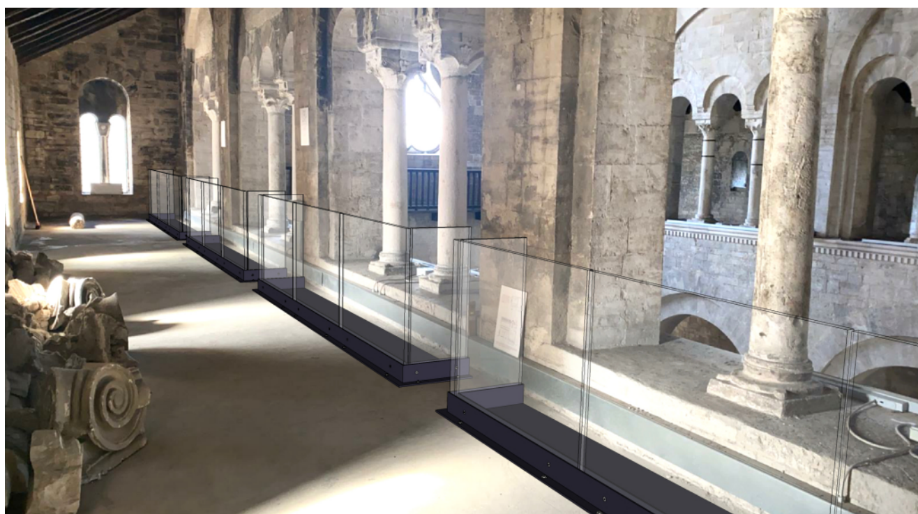
Matroneo nord: IPOTESI PROGETTUALE "A" Parapetto costituito da pannelli in vetro temperato extrachiaro fissato su basamento in acciaio verniciato
